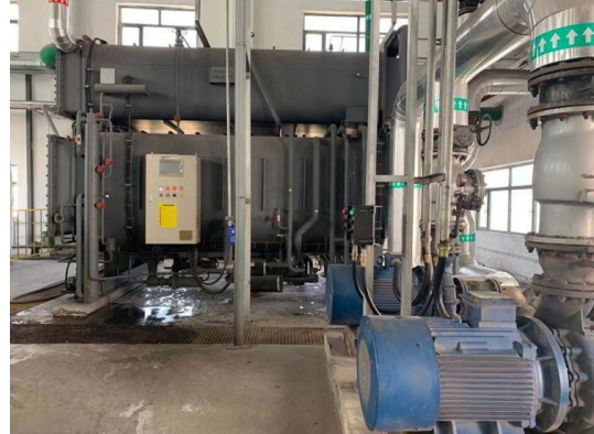
溴化锂机组制冷装置
