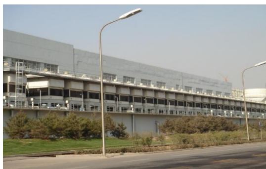
新炼钢水系统表面蒸发空冷器
