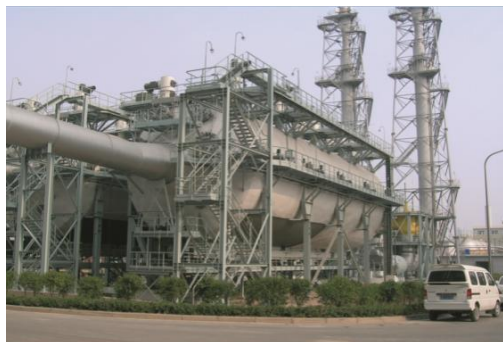
转炉煤气干法除尘
