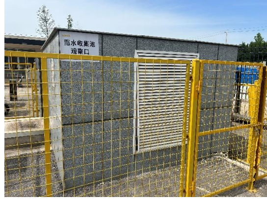
雨水回收装置
