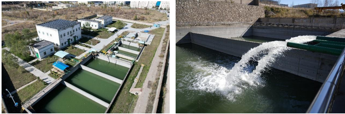
废水处理站雨水收集池
