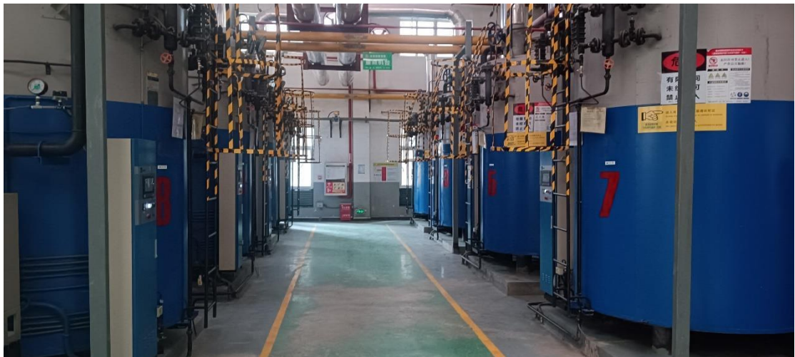
回收冷凝水用于锅炉软水
